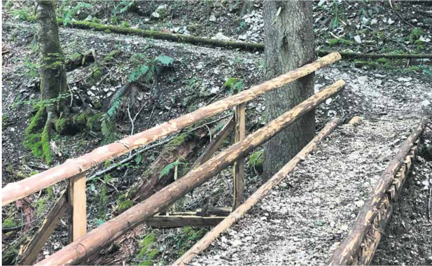
Ce pont a été érigé pour éviter de devoir passer dans le ruisseau de l'Iltsach
